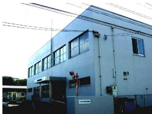
労基署外観(老朽)
