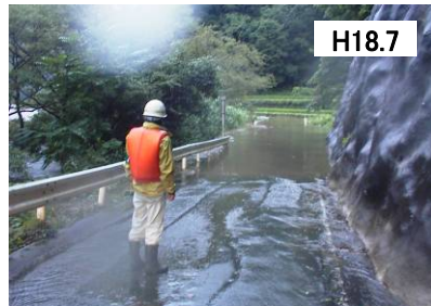
冠水による通行止めの状況
