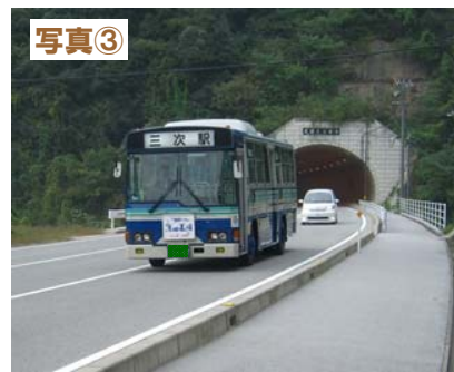
おおつ 大津トンネル
