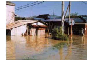
瀬戸内市長船町の浸水状況
