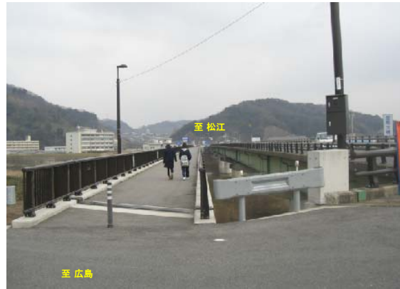
③ 里熊大橋側道橋(自転車歩行道橋)の状況 松江方面を望む
