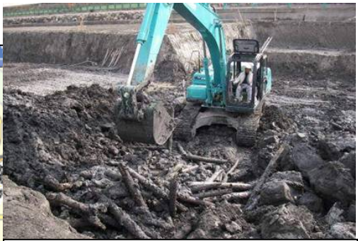
一部、粗朶沈床、木杭等の腐食物等を多数含む泥土があり、産業廃棄物処分を見込む
