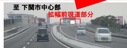
【写真A】入川橋付近(下り)
