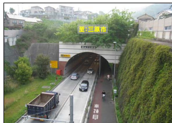
【写真②】西側抗口付近近景
