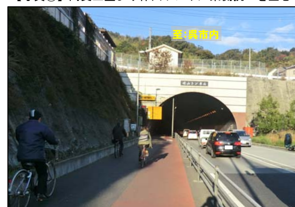
【写真③】東側抗口付近近景
