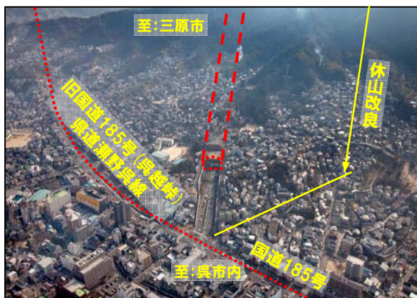
【写真①】呉市街上空より休山トンネル西側抗口を望む
