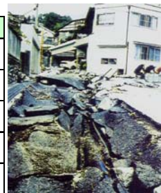
【写真】旧国道185号(呉越峠)の被災状況
