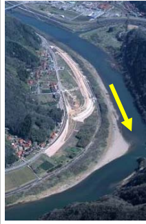
尾原地区の築堤事業
