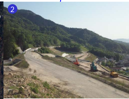
②東広島バイパス (H25年度供用予定区間) 中野東IC(仮称)付近を広島市内方向を望む
