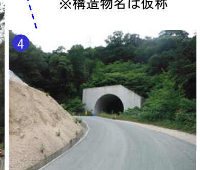
④安芸バイパス 大山トンネル起点側を望む
