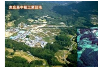
東広島中核工業団地
