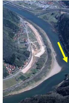
尾原地区の築堤事業
