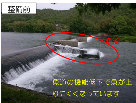
改善が必要な6基のうちの1例（鈴屋堰）
