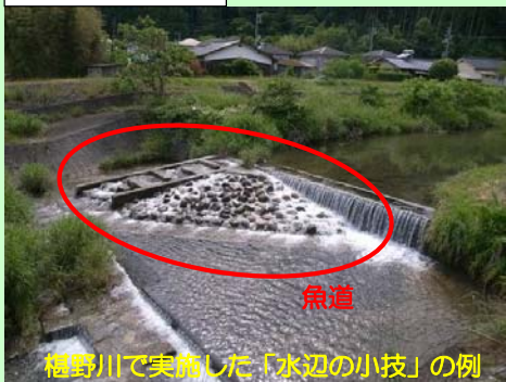
整備後の魚道の例
