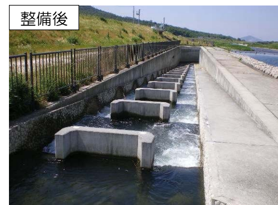
魚道の例（上右田堰）
