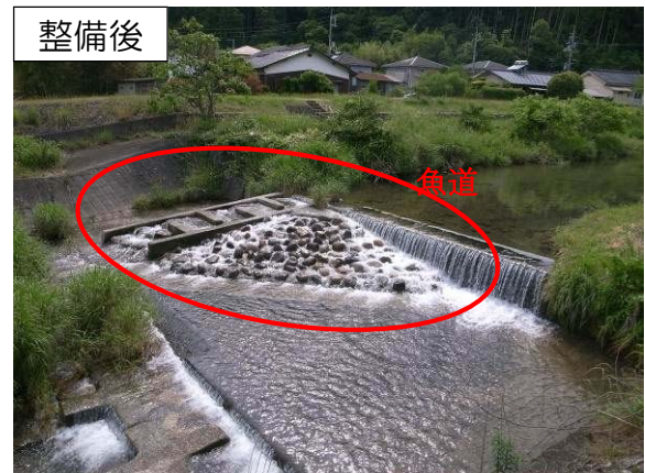
榎野川で実施した「水辺の小技」の例
