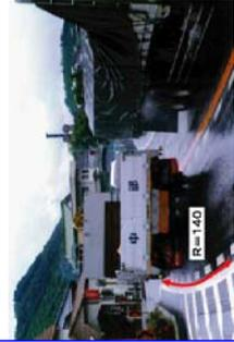
【写真①】平面線形不良箇所 (R=140)
