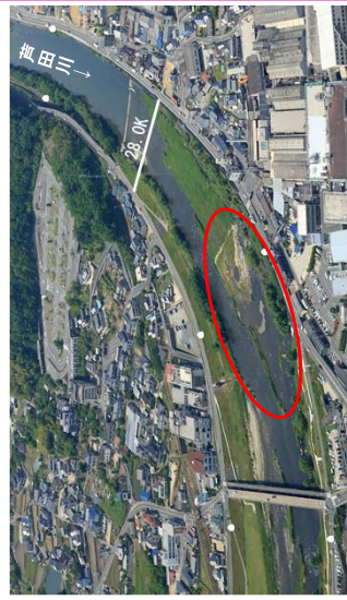
施工後（平成26年度撮影）
