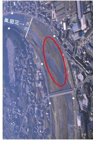
施工前（平成15年度撮影）
