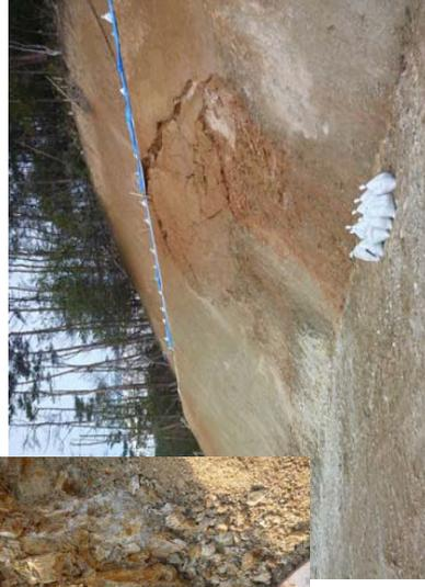
法面崩壊② 破砕質な地質による崩落
