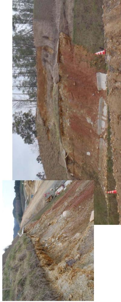
法面崩壊① 豪雨による法面崩落
