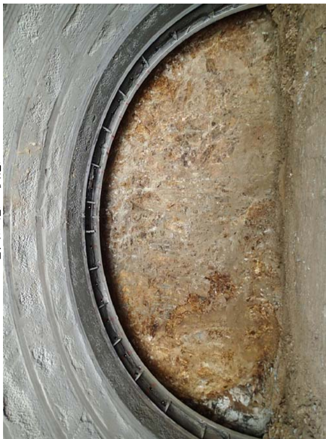
▼地山が悪い状態
