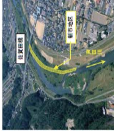
▲護岸整備箇所
