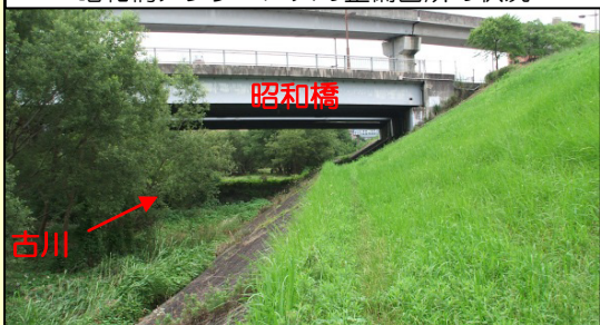
昭和橋アンダーパスの整備箇所の状況
