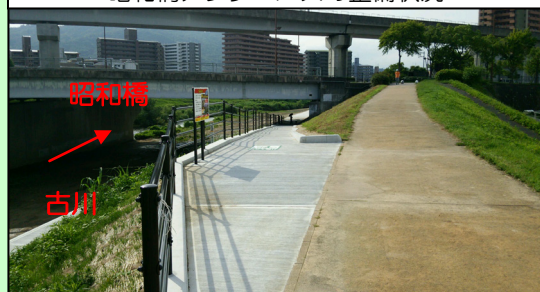
昭和橋アンダーパスの整備状況
