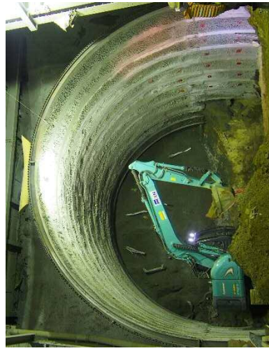
【写真③】 4車線化工事の様相 (掘削)
