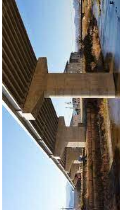
PC4径間連結プレテンションT桁橋
