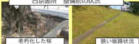
古京箇所 整備前の状況
