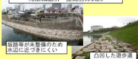
岡山城箇所 整備前の状況
