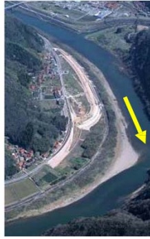
尾原地区の築堤事業
