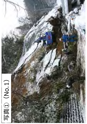
平成17年1月法面崩壊 (国道183号庄原市西城町) 【全面通行止め106時間, 片側交互通行350日】
