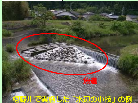
整備後の魚道の例
