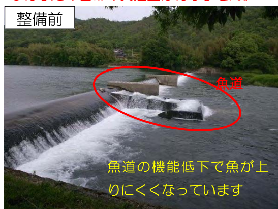
改善が必要な6基のうちの1例（鈴屋堰）
