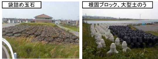
備蓄資材保管状況
