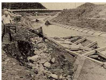
④ 昭和47年7月洪水による 白上川の被災状況
