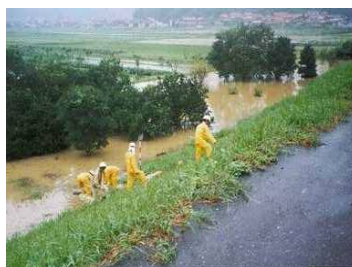
⑥ 平成9年7月洪水による堤防 法尻への水防活動状況
