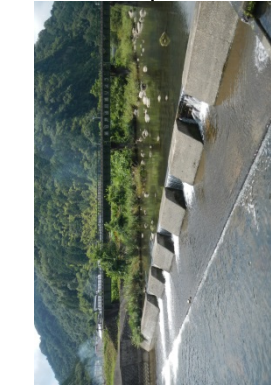
④ 遡上降下を妨げている横断構造物
