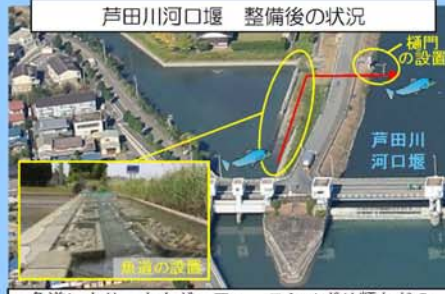
芦田川河口堰 整備後の状況
