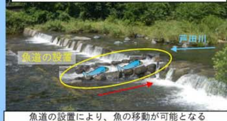
魚道の設置により、魚の移動が可能となる
