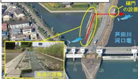
魚道により、ウナギ、アユ、ヨシノボリ類などの回遊魚や、モズクガニ、テナガエビなどの回遊性動物が移動（遡上）している
