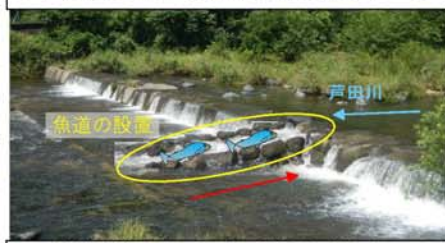
魚道の設置により、魚の移動が可能となる
