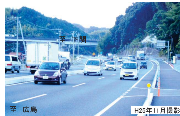
【写真②】戸田拡幅整備済区間
