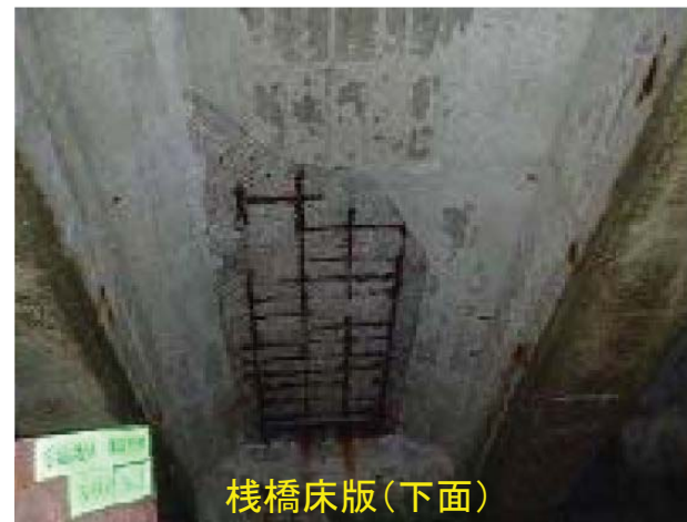
栈橋の老朽化状況
