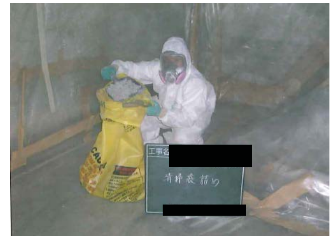
封じ込めによる除去作業(イメージ)
