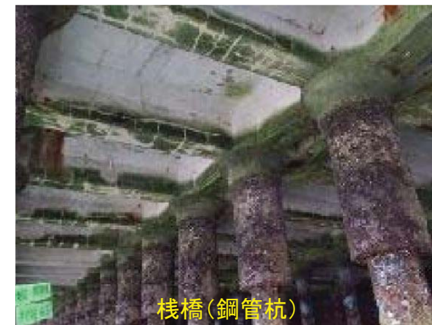
栈橋の老朽化状況
