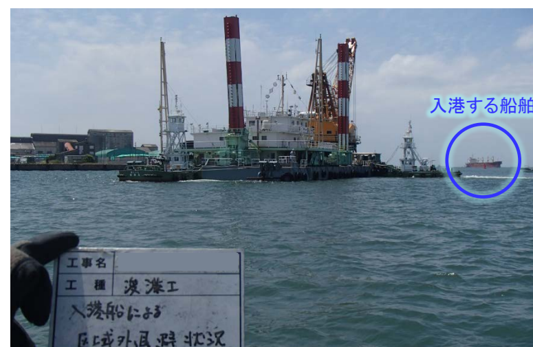
浚渫船退避状況
