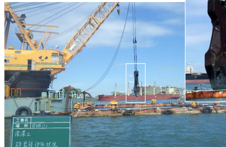
砕岩棒による破碎状況
