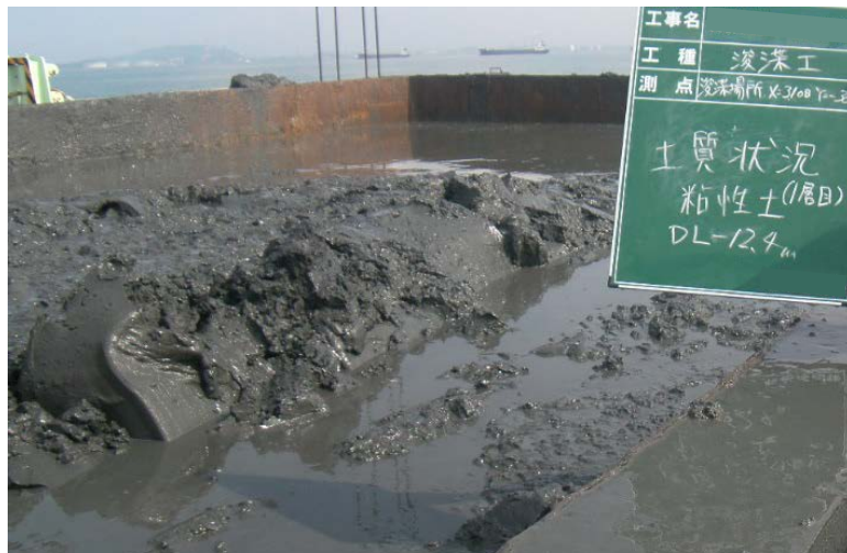
浚渫土砂(粘土質土砂)
