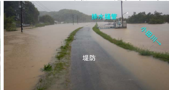
堤防からの越水の発生状況
