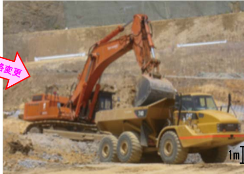
バックホウ4.0m 3 ダンプトラック32tでの施工に見直し
