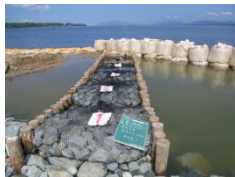
消波工設置状況
