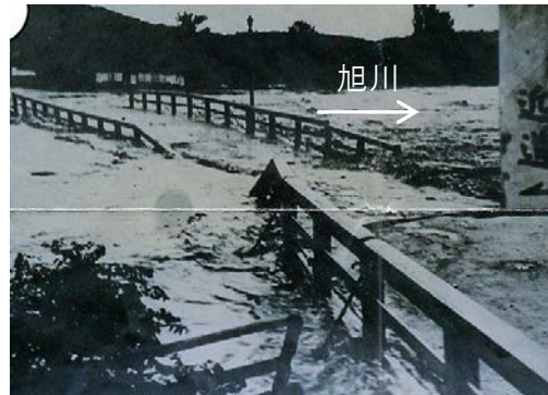
昭和9年9月旭川氾濫の様子(岡山市) 岡山市松浦氏提供
