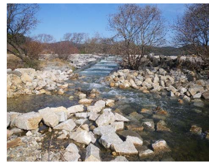
既設魚道を活用した周辺環境の 改善状況(魚道入口の落差解消等)
