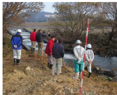
関係機関と現地立会
