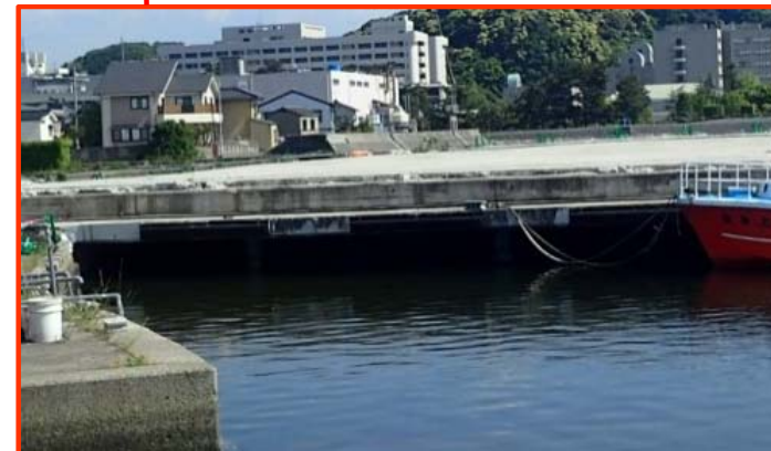
直立した護岸で段差があるため、 利用が限定的となっている。
