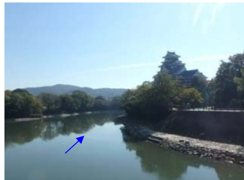
水辺を安全に利用するための 河川管理用通路がない
