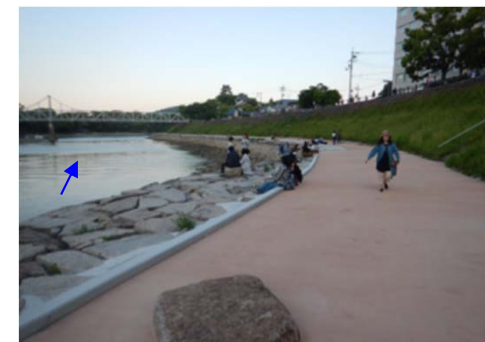
安全に水辺を回遊することができる (整備済箇所)
