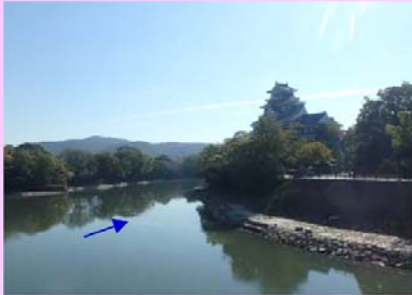
岡山城箇所 整備前の状況
