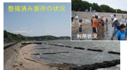
動植物が生息できる場が形成され、自然浄化機能が向上、波が小さくなり透明度が向上
