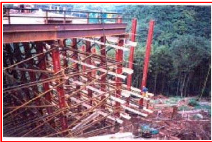
標準工法(H鋼杭式栈橋)
