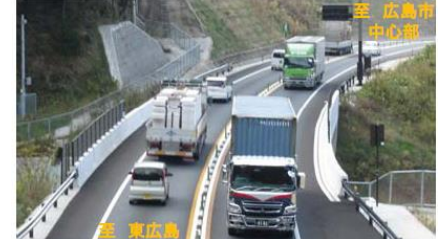
東広島バイパス 中野東IC付近から広島方向を望む
