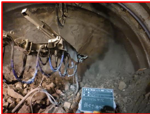
▲ コンクリート吹付の実施状況
