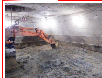
■ 基礎先端部における掘削状況
