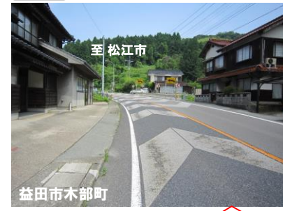
線形不良箇所(R=100)
