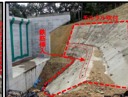
法面にモルタル吹付や、鉄筋挿入等の崩落対策を実施
