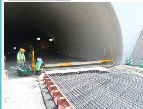
連続鉄筋コンクリート舗装：横目地無し
