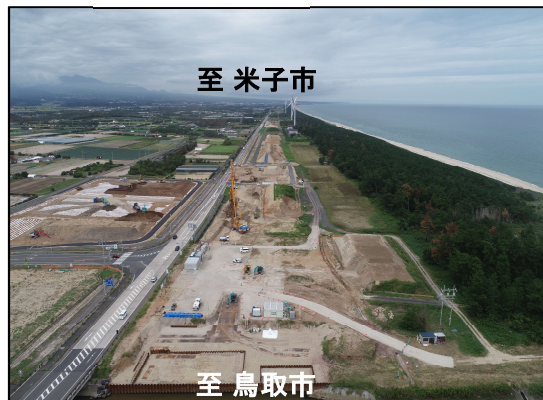
①北条JCT(仮称)周辺より米子市方面を望む
