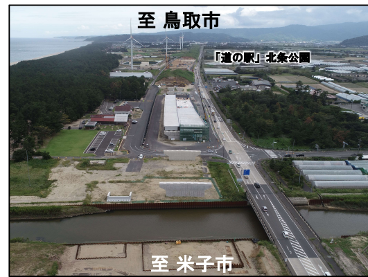
②米子方面より北条IC(仮称)を望む
