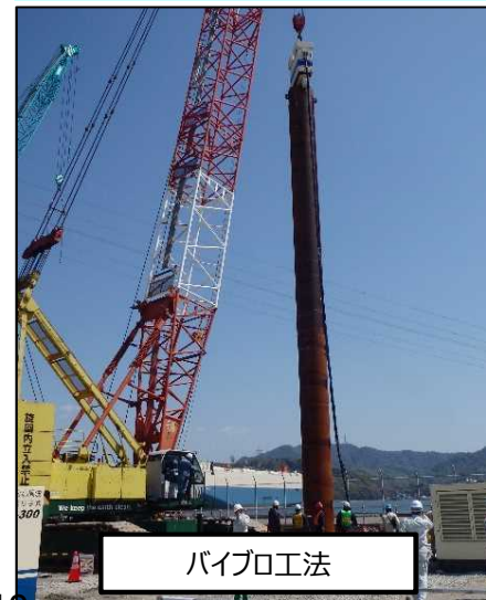
当初の鋼管矢板打設工法
