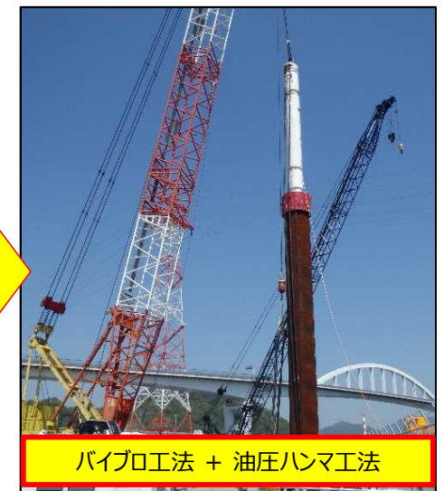
変更後の鋼管矢板打設工法
