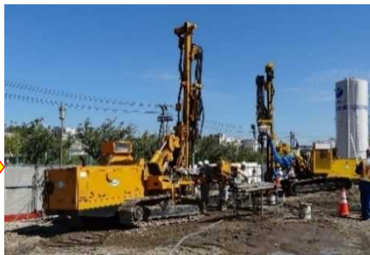
砂圧入式静的締固め工法 (SAVE-SP)
