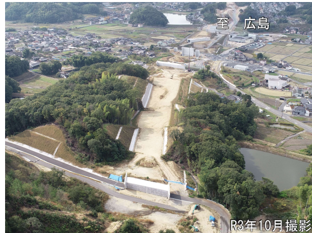
【写真②】鴨方IC(仮称)付近の進捗状況
