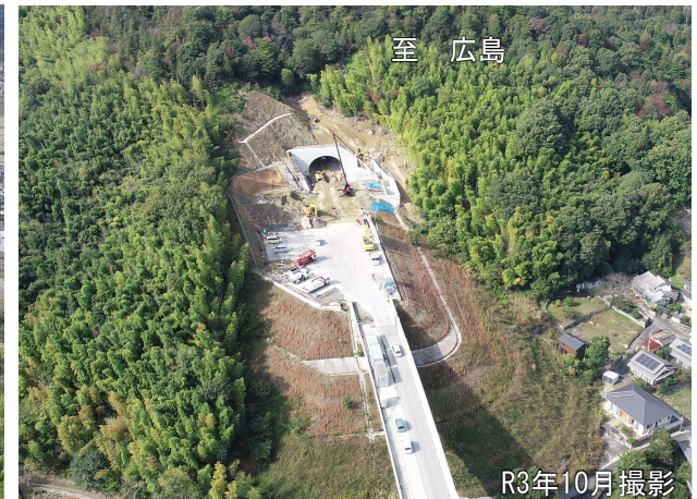
【写真③】六条院トンネル付近の進捗状況
