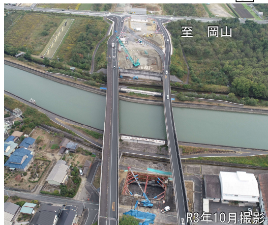
【写真①】笠岡東IC(仮称)付近の進捗状況
