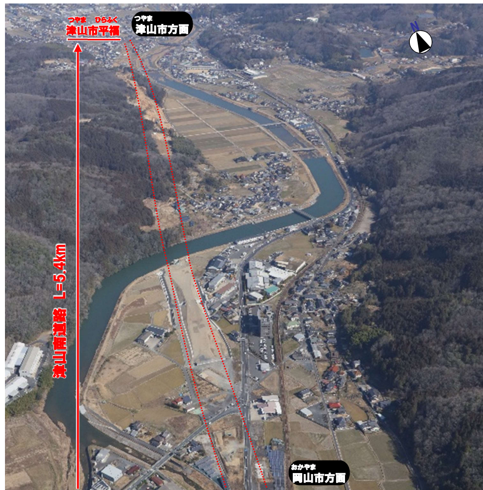
起点側(岡山市方面)より北方面(津山市方面)を望む[令和3年3月撮影]
