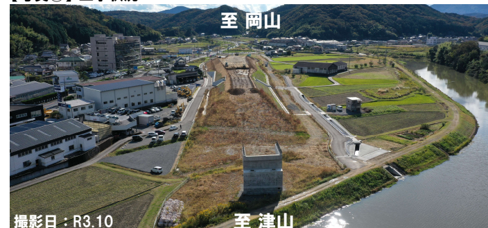
【写真③】工事状況
