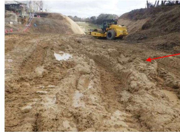
※泥濁化: 降雨時など、水を含んだシルト・砂が分離して路面の表面がぬかっている状態
