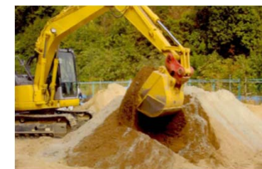
現地発生土とセメントの攪拌状況
