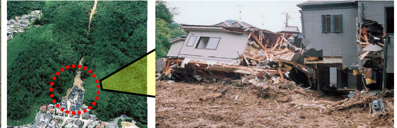
やすかわ 安川左支川の土石流氾濫状況
