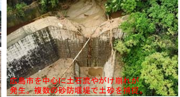
相田1号砂防堰堤の土砂捕捉状況
