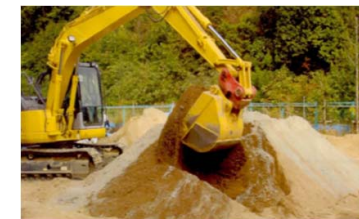
現地発生土とセメントの攪拌状況
