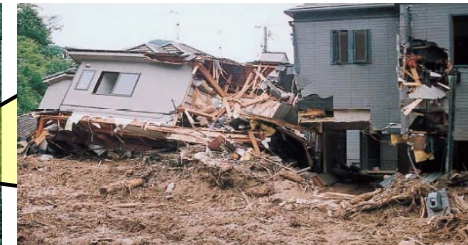
やすかわ 安川左支川の土石流氾濫状況
