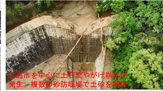
相田1号砂防堰堤の土砂捕捉状況
