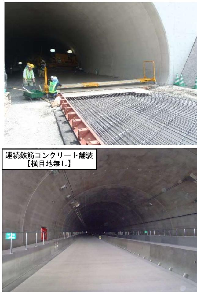
連続鉄筋コンクリート舗装
