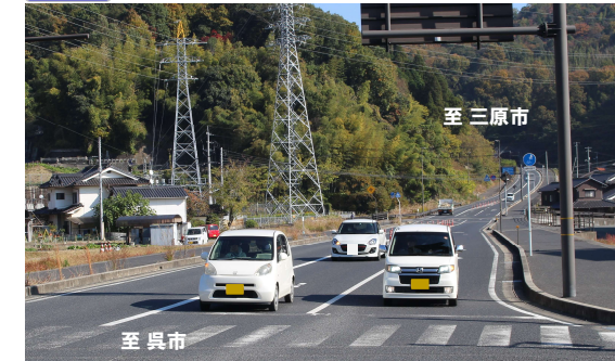
(主)安芸津下三永線付近から鎌倉トンネルを望む
