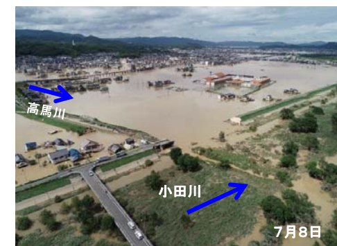
平成30年7月豪雨被災直後 (小田川左岸3k400付近)
