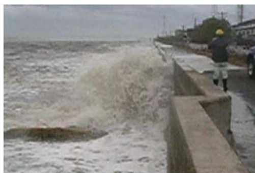
高梁川の高潮越波状況(平成16年台風16号)
