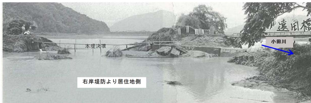
小田川の堤防決壊による浸水状況(昭和47年7月豪雨)
