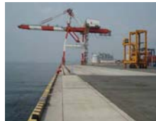
■ 福山港耐震強化岸壁
